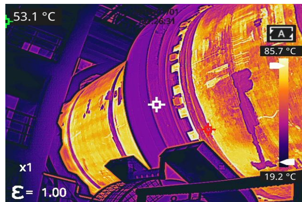
Figure 7.4 로터리 킬른 외벽 내화물 검사
